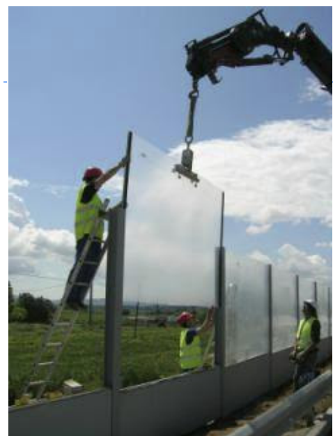
Instalación de una lámina vitroflex ® NOISE BARRIER
